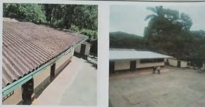
Foto 2: MODULO A cambio de cubierta de asbesto por lamina troquelada cal 26.
