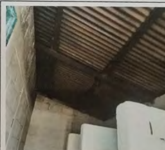
Foto 10: MODULO D se cambio estructura de metal y se sustituyo la lamina de zinc en mal estado por lamina troquelada cal 26
