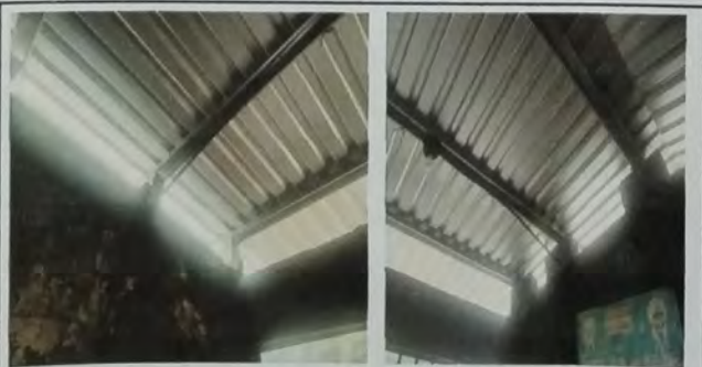
Foto 5: MODULO B Vista interna de aula, cambio de cubierta de asbesto por lamina troquelada cal 26. Se instalo estructura de metal a base dde costaneras de metal.
