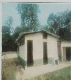
Foto 7: MODULO D Servicios Sanitarios, cambio de lamina de zinc por lamina troquelada cal 26.
