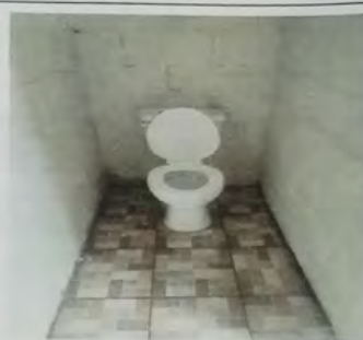
Foto 8: MODULO D vista interna de cubiculo de sanitarios, se cambio el piso ceramico y se cambio el sanitario.
