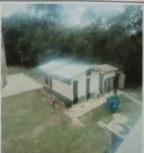
Foto 11: MODULO D SERVICIOS SANITARIOS Y COCINA se cambio estructura de metal y se sustituyo la lamina de zinc en mal estado por lamina troquelada cal 26
