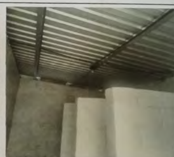
Foto 10: MODULO D se cambio estructura de metal y se sustituyo la lamina de zinc en mal estado por lamina troquelada cal 26
