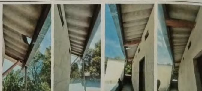
Foto 12: MODULO C Vista de cambio de laminas de asbesto que estaban dañadas.
