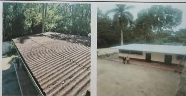
Foto 4: MODULO B cambio de cubierta de asbesto por lamina troquelada cal 26. Se instalo estructura de metal a base dde costaneras de metal.
