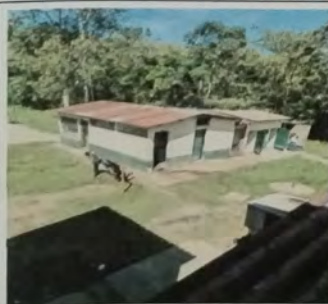
Foto 11: MODULO D SERVICIOS SANITARIOS Y COCINA se cambio estructura de metal y se sustituyo la lamina de zinc en mal estado por lamina troquelada cal 26
