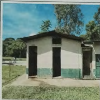
Foto 7: MODULO D Servicios Sanitarios, cambio de lamina de zinc por lamina troquelada cal 26.
