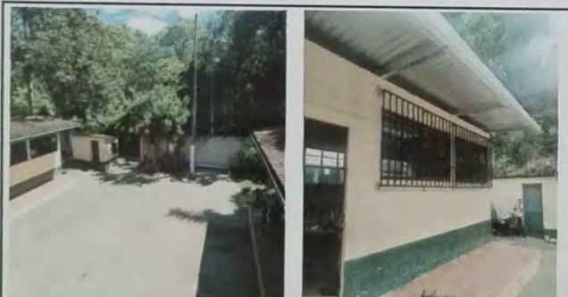
Foto 3: MODULO A cambio de cubierta de asbesto por lamina troquelada cal 26. Se instalo estructura de metal a base de costaneras de metal. Se instalaron balcones en vanos de ventaneria.
