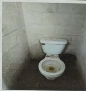
Foto 8: MODULO D vista interna de cubiculo de sanitarios, se cambio el piso ceramico y se cambio el sanitario.
