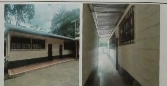
Foto 6: MODULO B Vista de corredor, cambio de cubierta de asbesto por lamina troquelada cal 26. Se instalo estructura de metal a base dde costaneras de metal. Se instalaron balcones en vanos de ventaneria.
